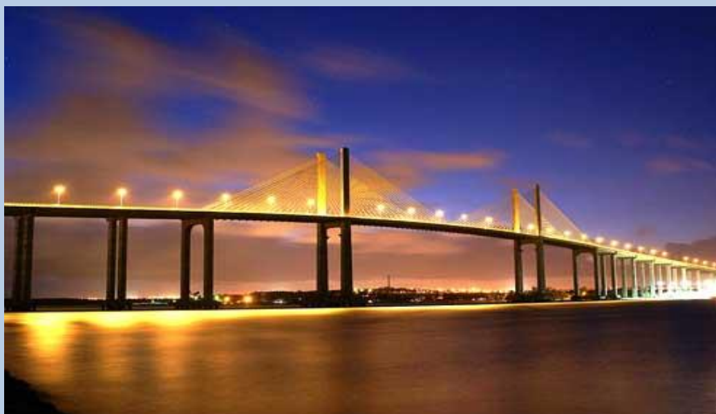
Ponte sobre o Rio Madeira - Rondônia
